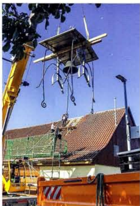
8 Gemeinsame Montage mit Zimmerer und Bauhof-Mitarbeitern
