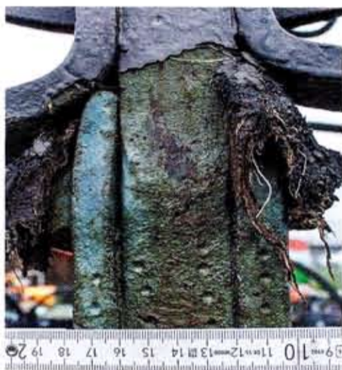
4 Detail mit Schlagmarken und originaler Farbfassung
