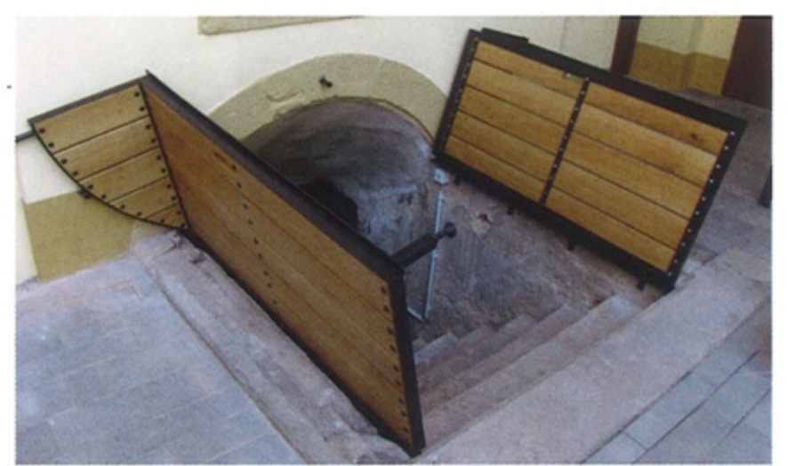
Kellerabdeckung für einen Altbau in Mannheim. Die Beplankung besteht aus Eichenholz
